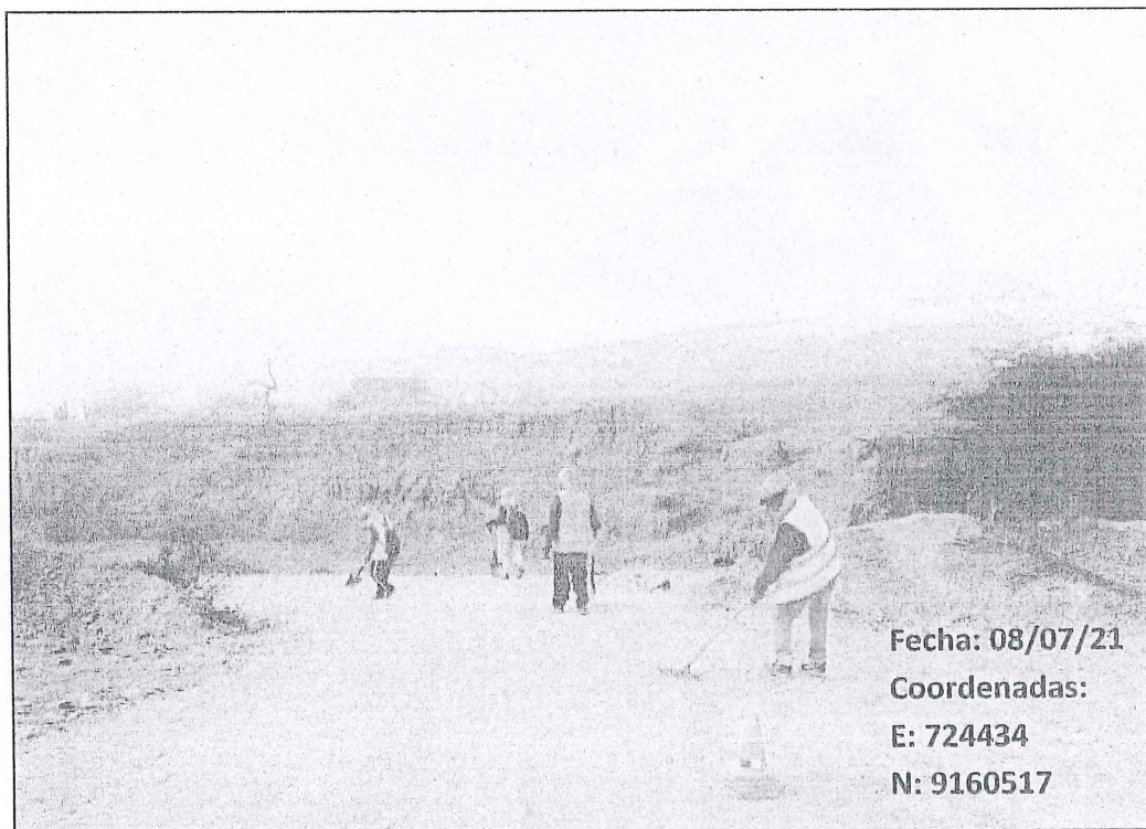
Foto N° 08: Perfilado de la superficie sin aporte de material.
