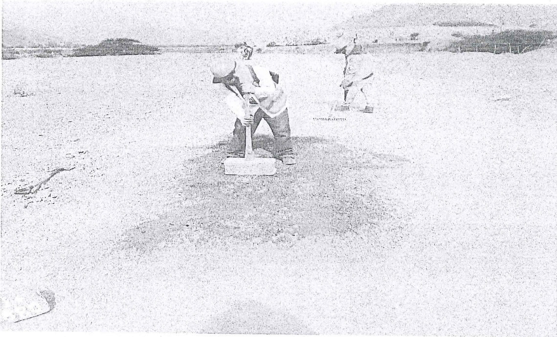
FOTOGRAFIA N°11: CAMINO CON BACHEO Y RASTRILLADO DE LIMPIEZA
